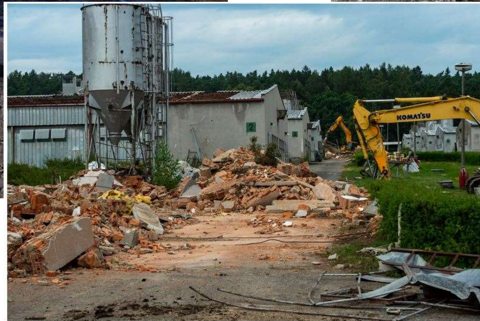
Actual status of demolition works
